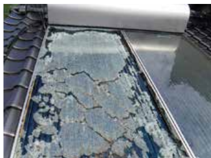
太陽熱温水器の損傷
