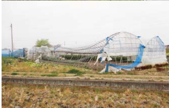
令和4年3月26日の強風により、本体骨組が吹きとばされたハ ウス(上)、本体骨組が押しつぶされ変形したハウス(下)
