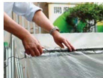
被覆材を固定するスプリングを交換
