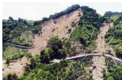
大きく流失した園地
