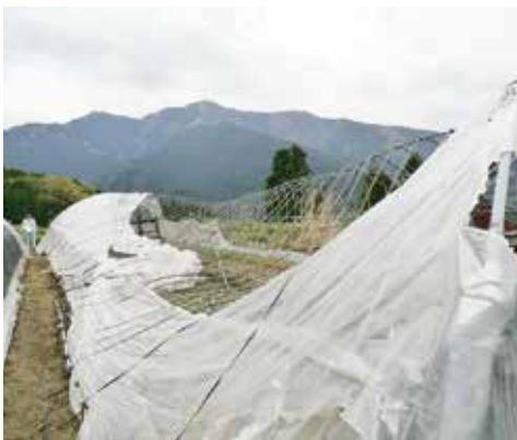
風害で倒壊したハウス
