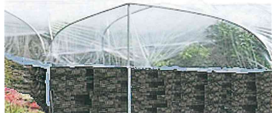
屋根面のみ、プラスチックフィルムで被覆されているタイプ 屋根面のみ、または全面をネットで被覆されているタイプ
